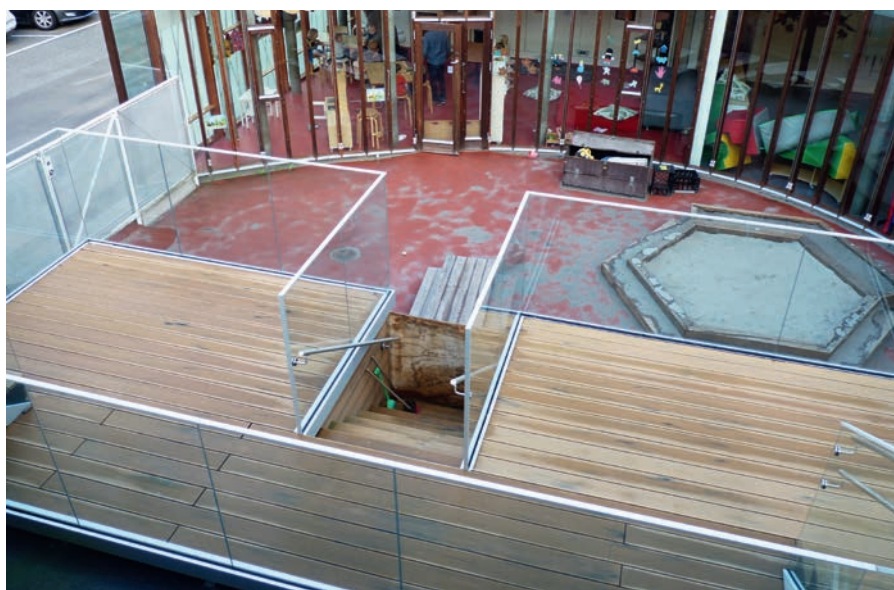
Et eksempel på sand oprydningsarbejde
